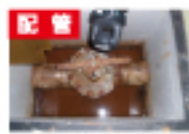
配管 配管スペースの掃除に!
