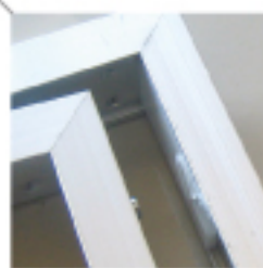
内枠と外枠、取付部分 ※内枠(内枠)取付は斜め方向に力を入れて下さい
